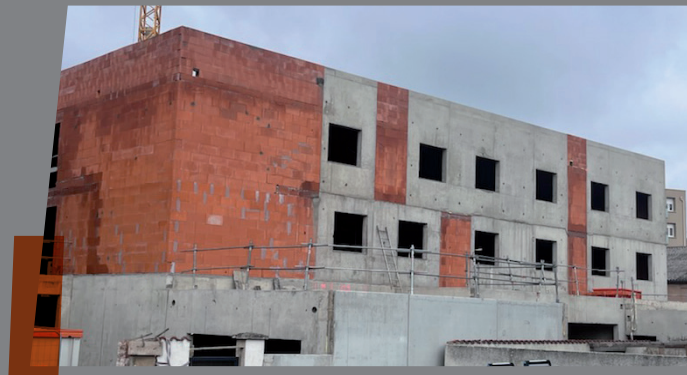
Avancement du chantier mars 2023
